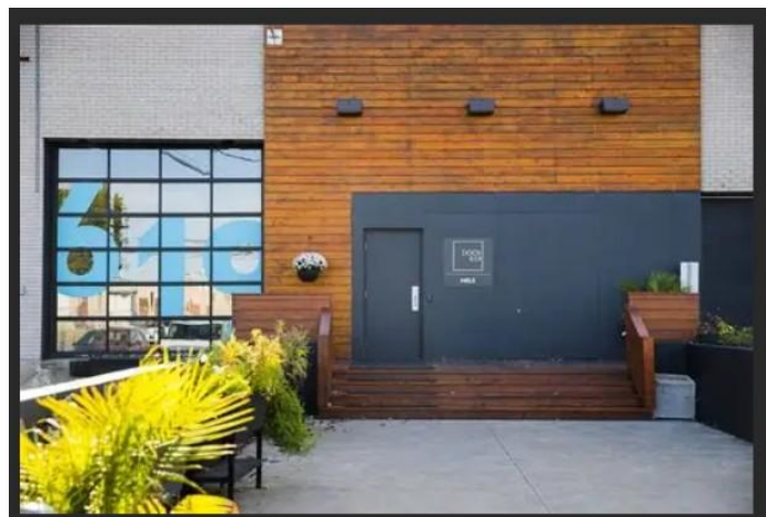
Porte d'entrée à l'arrière de l'édifice
